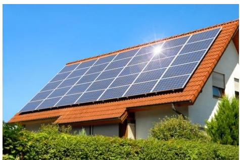
Parmi les cellules photoélectriques, on peut citer les cellules photovoltaïques. Sous l'effet de la lumière, une tension électrique apparaît entre leurs faces: ce sont des générateurs. Elles convertissent l'énergie lumineuse en énergie électrique.
